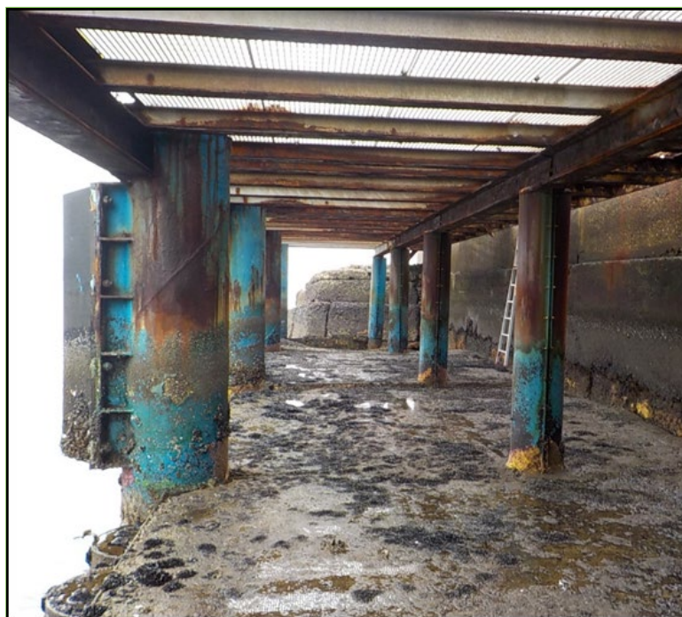
現況写真②棧橋下部
