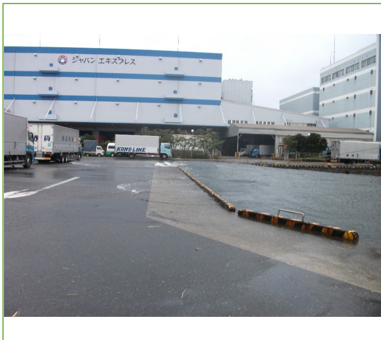
現況写真① (高潮時冠水状況)
