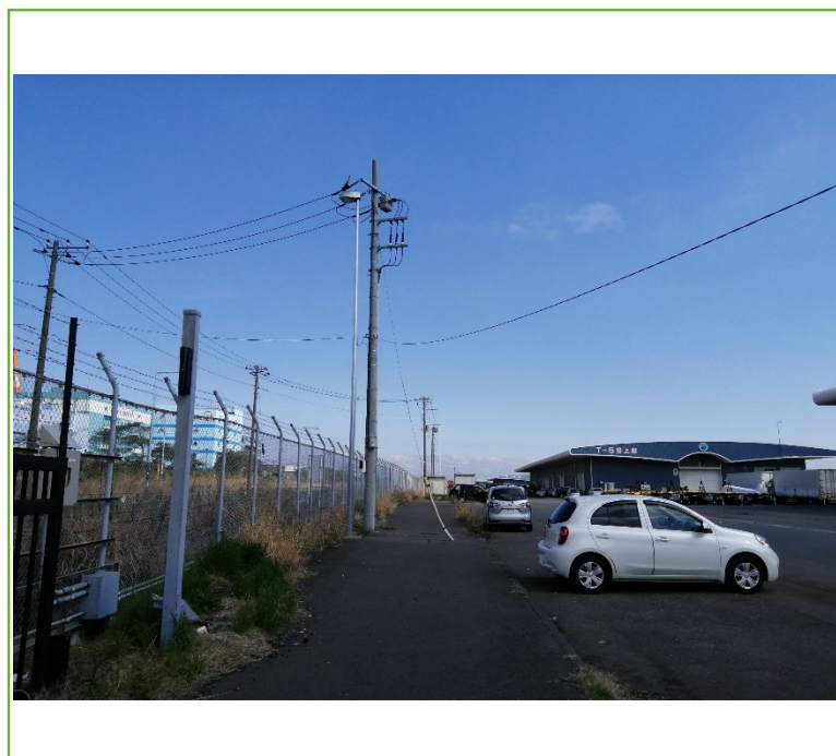
現況写真(止水壁整備箇所)
