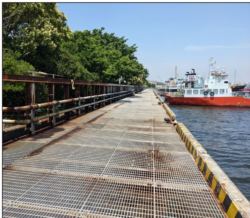
現況写真①棧橋上部
