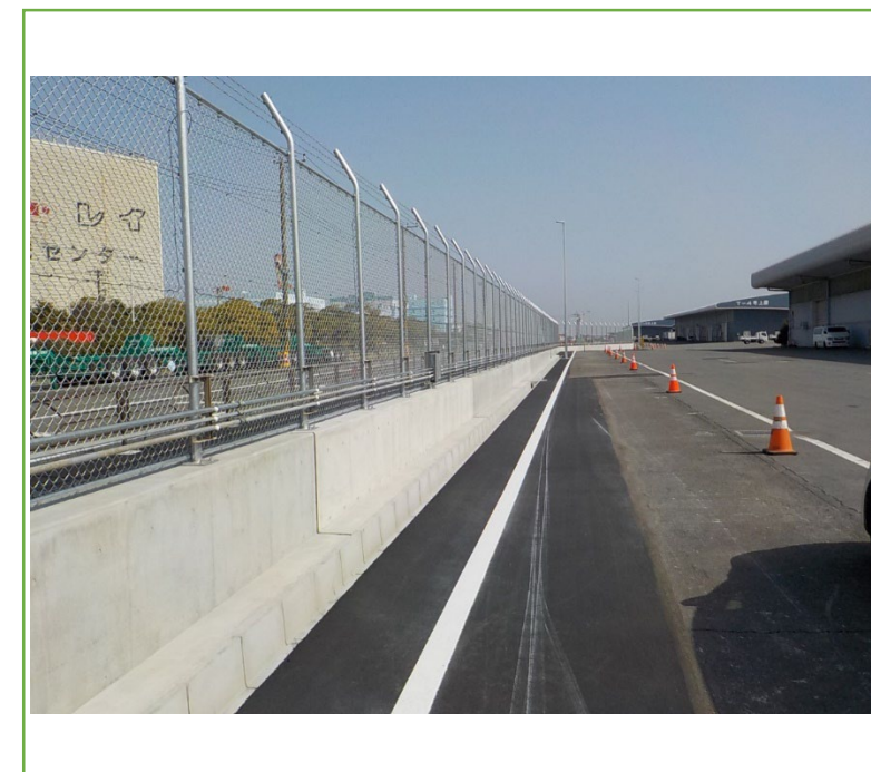
止水壁施工例
