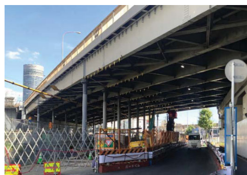
新横浜陸橋（港北区）
