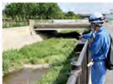
土砂堆積調査(目視点検)
