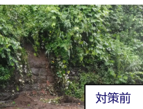
防護柵の設置
