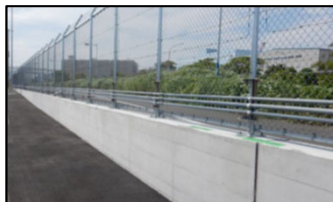
海岸保全施設（止水壁）
