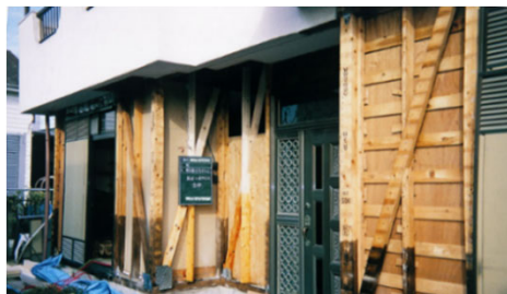
木造家屋耐震補強工事の例
