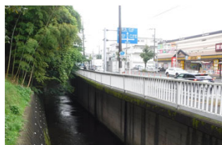
緊急輸送路に隣接した護岸(特殊堤)
