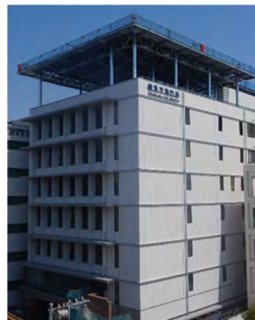
< 消防本部庁舎 >
