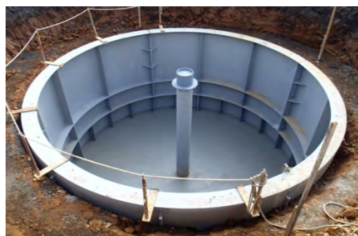
<防火水槽新設工事>
