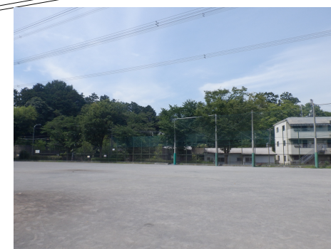
防球フェンスの改修
