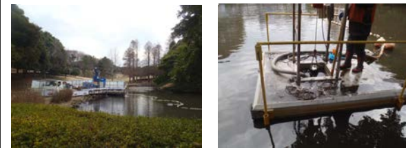
池浚渫を行った事例（根岸森林公園）
