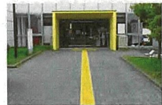
正面入口にある点字ブロック
